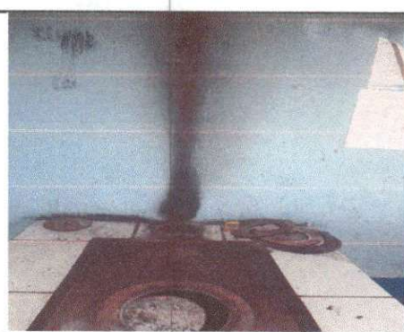
Foto 6: Sustitución de chimineas de metal por concreto
