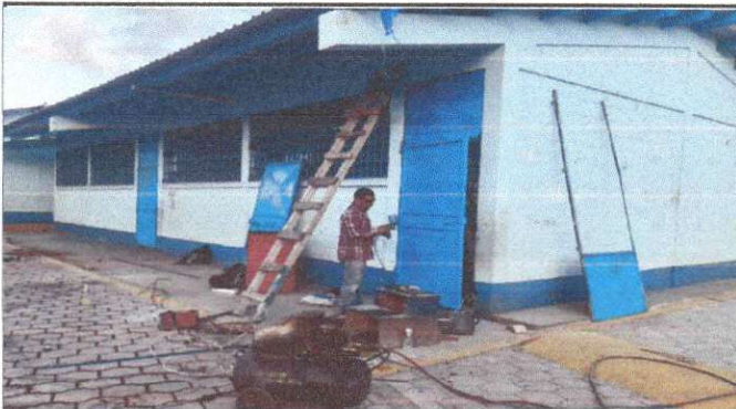
Foto 3: sustitucion de puerta (modulo 1)
