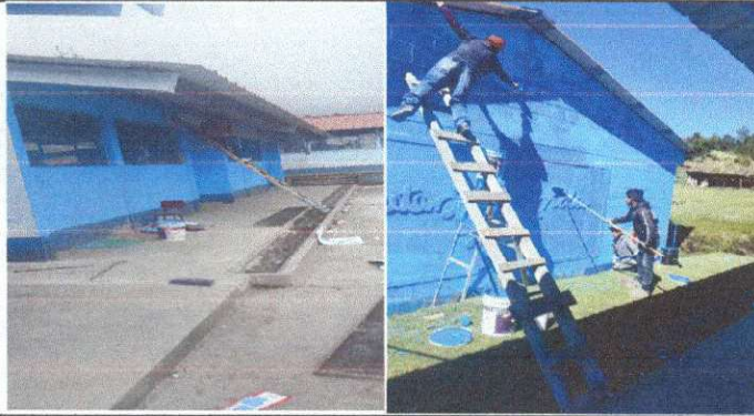
Foto7: Pintura en muros exteriores (modulo 1)
