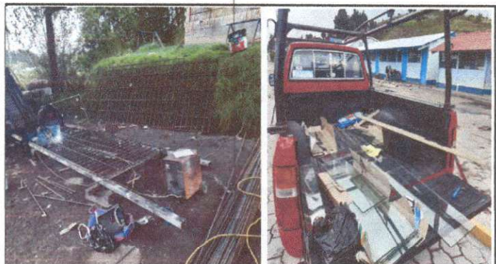
Foto 4: Sustitución balcones de metal, (modulo 1)
