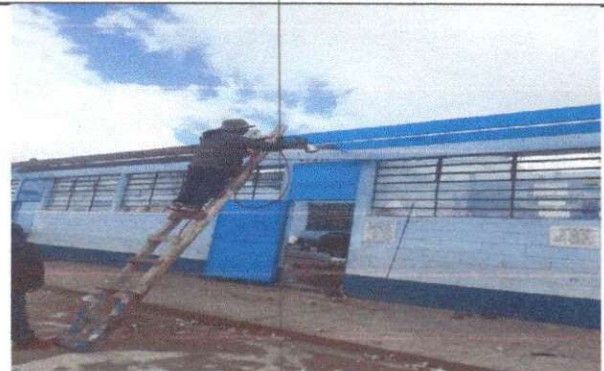
Foto 2: Mantenimiento de estructura de metal (modulo 1.)
