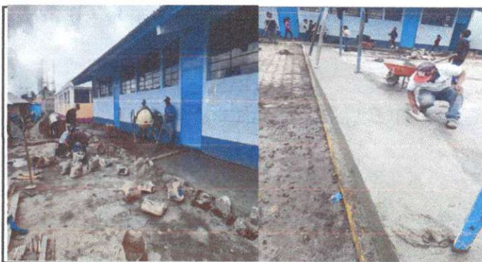
Foto 5: Sustitución del piso de torta de concreto (patio)
